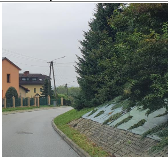
Zabezpieczenie skarp płytą betonową ażurową. Agrowłóknina nie jest zalecana do roślin.
